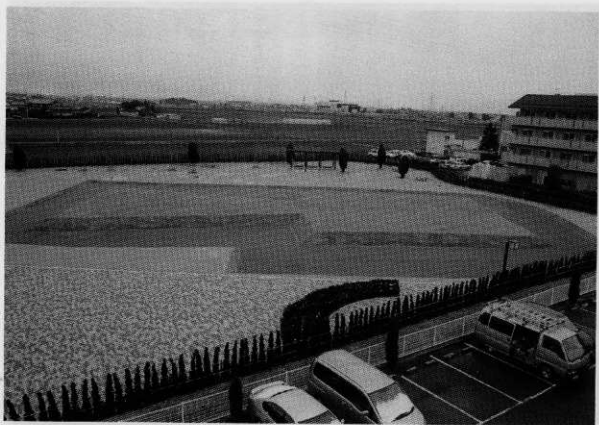
平成17年度保存整備工事 全景（南から）
