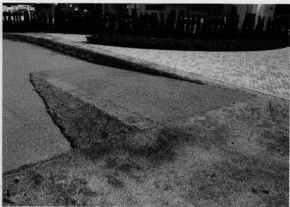
平成18年度保存整備工事 スロープ
