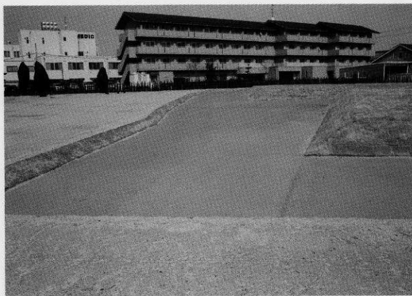
平成17年度保存整備工事 透水性脱色アスファルト舗装・張芝
