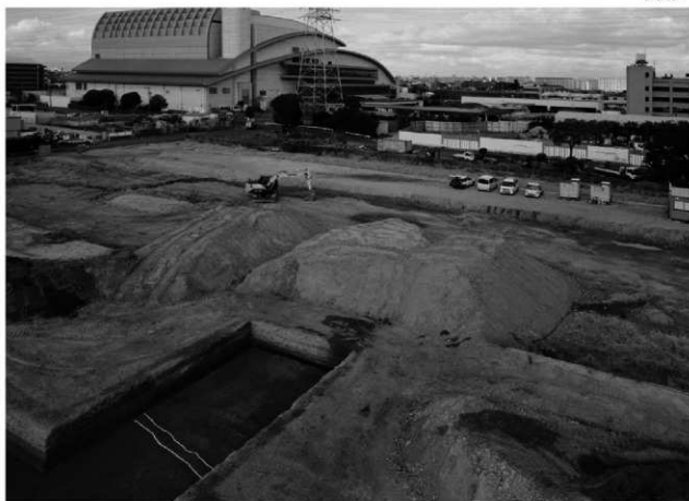
1. 7区北西方向遠景（南東から）
