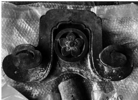
28. 復原製作瓦大棟鬼瓦
