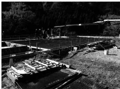
40. ベースコンクリート打ち
