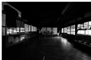
内部柱を抜いて板の間に改造
