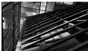
縁側野垂木 (写真一)
