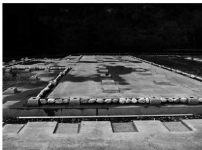
41. 礎石・差し石 据付完了
