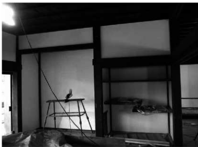
67. 内部漆喰塗り
