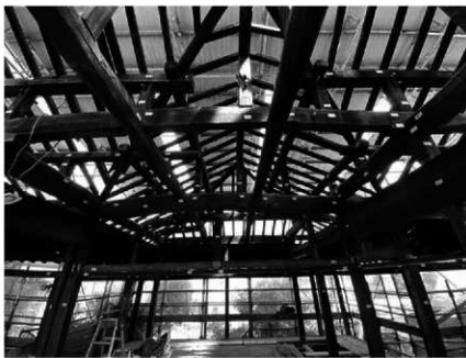
34. 野地板・壁等解体
