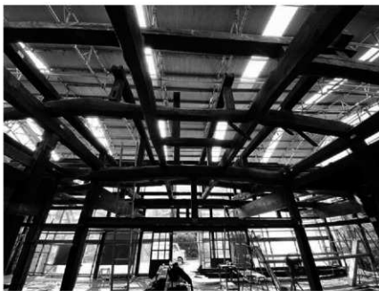
35. 垂木・造作材解体
