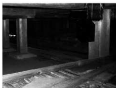
床下保存状況
