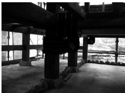
62. ガルコン柱・足固め 古材部分取付
