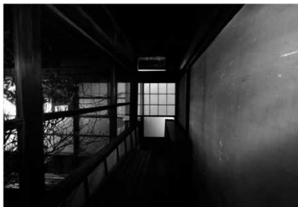
22. 座敷10帖外縁側西面
