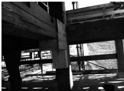
61. 床下制震金物 (ガルコン) 取付け部分古材養生
