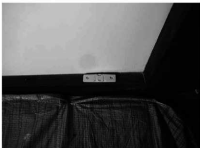
69. 電気器具取付 コンセント
