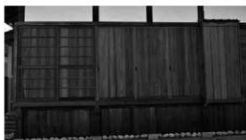
北面外部開口部東側
