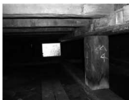
外部コンクリート基礎
