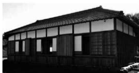
北面外部開口部西側
