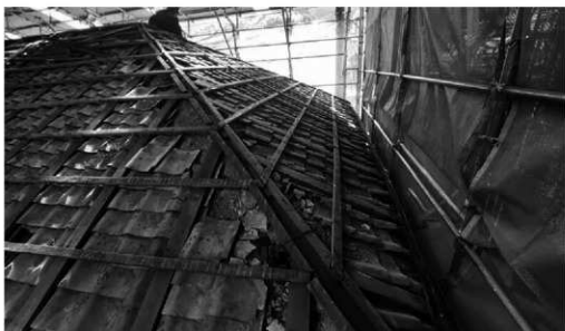
26. 屋根トタン撤去
