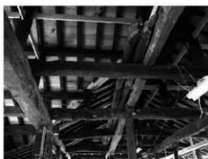
小屋裏保存状況
