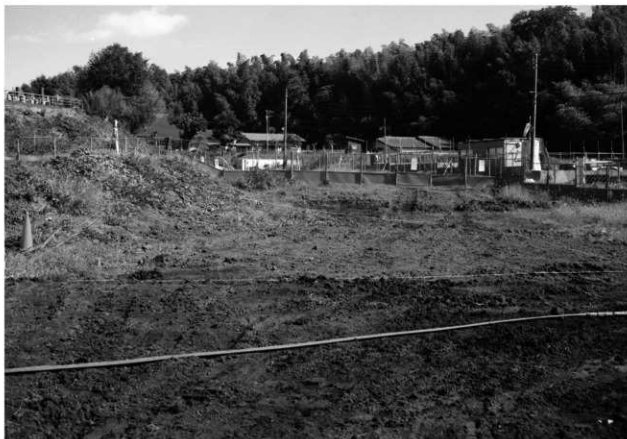
1 栗窪・林窪道路 8区 調査開始前（南から）
