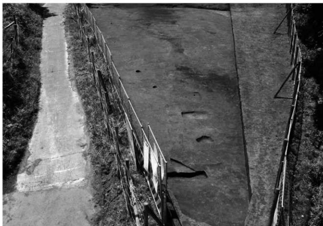
2 東富岡・太孫道跡 2区 B・C 22～24グリッド近世面全景（東から）
