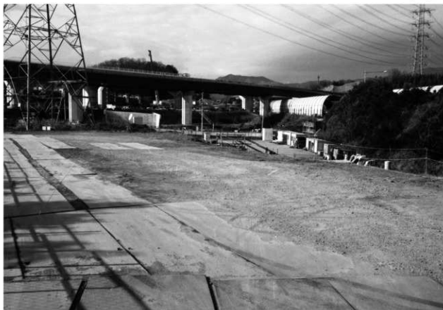
1 東富岡・太窪道跡 1区 調査開始前（東から）
