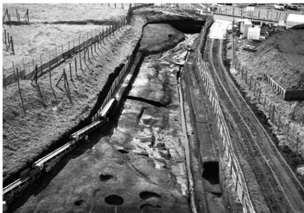
1 東富岡・太隆道峠 1区 C1号流路（東から）
