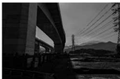
新東名高速道路建設後の現況（左手前の橋脚がピア16（上り）区：東から）2024.06撮影
