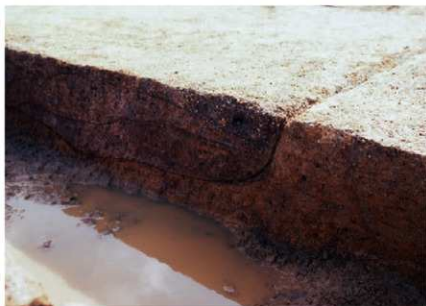
65-3 次(HO08D-s) 内裏東地区西面築地塀 S A01001 断削(北から)
