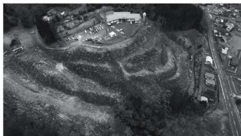
写真 43 ◀ 伐採後空撮 (北東から)
