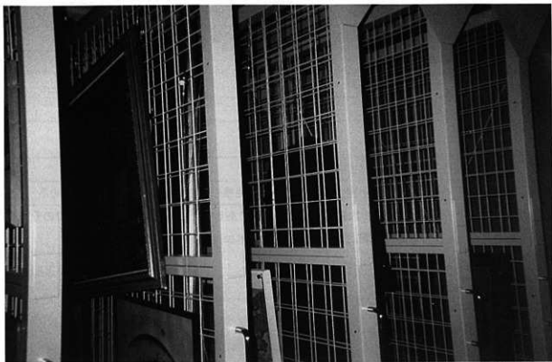
◇ 絵画ラック設置工事
