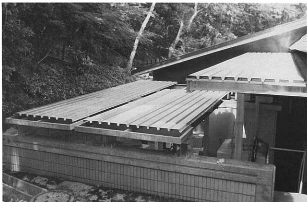
屋外機置場整備工事
