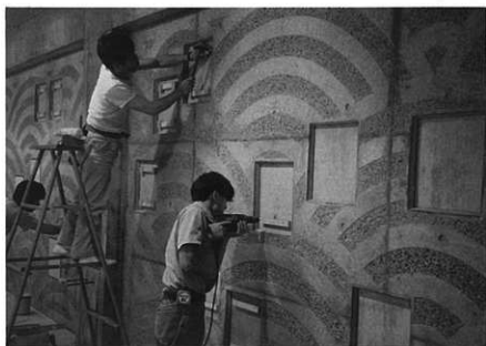
展示ホール エッチング加工板取付
