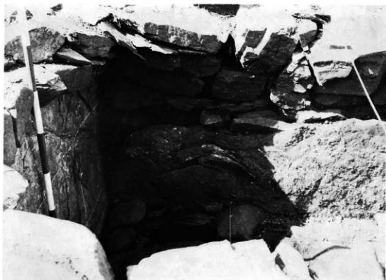
石室西壁の石材構架状況
