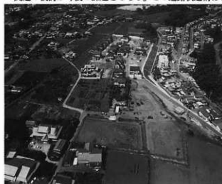
第120図 調査区（1・2・3区）全景
