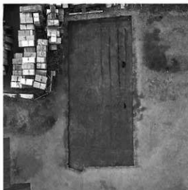
第88図 A区全景
