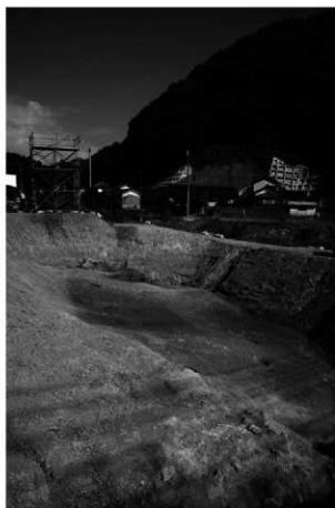
最終面完掘状況（南西から）
