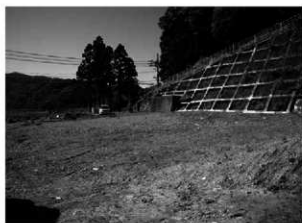
令和 6 年度調査着手前の状況 (北から)
