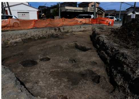
8 第1調査区第2遺構面完掘状況（南東から）
