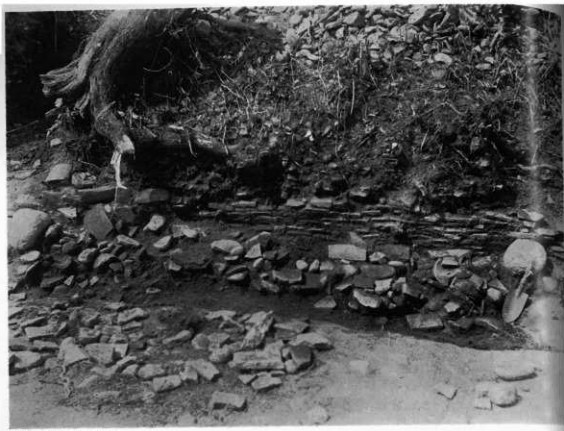
基壇瓦積全景
