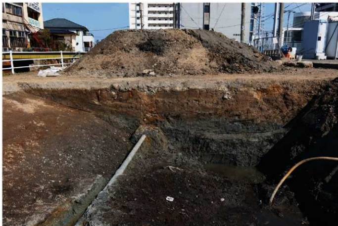
1. 東側壁面土層堆積状況（西から）
