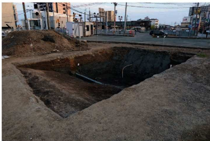
2. S-2 完掘状況（北西から）
