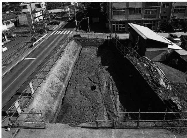
C2区第3-1遺構面全景 (西から)
