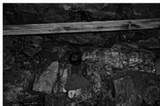
2区石堤裏法基底部胴木留杭：サブトレッチ2（東から）
