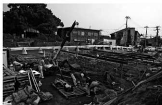
2区石堤解体状況（南西から）
