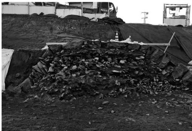
2区南端石堤断面（北から）
