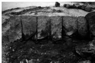
3-1区擁壁部石堤表法3段目上面（東から）
