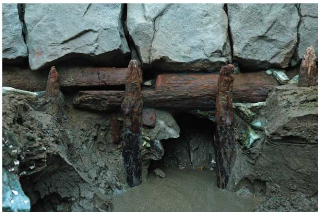
3-1 区石堤表法底部（西から）
