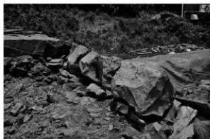
写真 5 3区石堤裏法上段砂岩列 (南西から)
