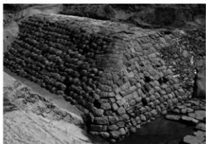
図-2 水軒堤防南端部の全景(海側から) 和歌山県教育委員会提供
