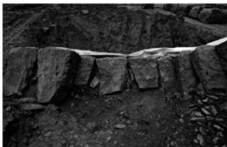
3-1区擁壁部石堤表法7段目上面（東から）
