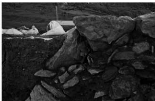
2区石堤裏法上段山土貼付け状況（北から）
