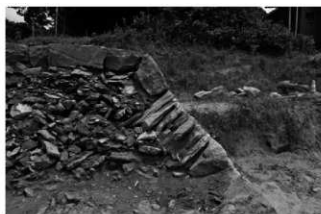
3-1区南端石堤裏法断面（南から）
