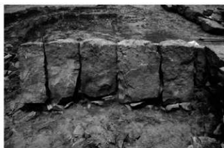
3-1区擁壁部石堤表法1段目上面（東から）
