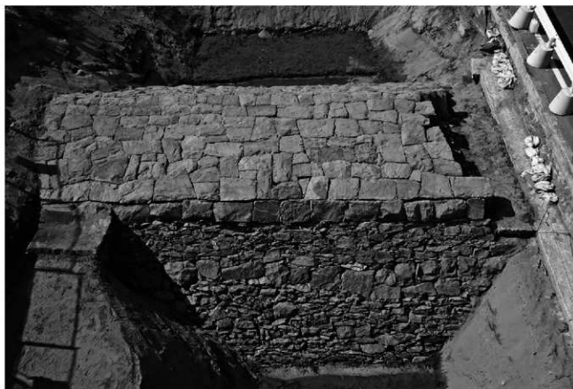
2区石堤天端・裏法全景（東から）
