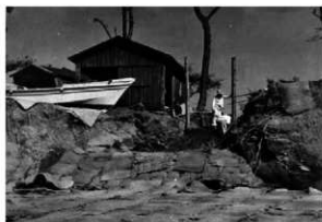
図-10 第二室戸台風によって被災した水軒堤防 (堤防の天端上に船が打ち上げられている) (和歌山県立文書館所有)
