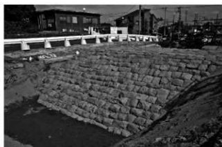
2区石堤表法全景（南西から）
