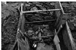
2区石堤裏法基底部：サブトレッチ2（東から）
