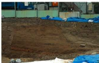
2区中堤防上堆積土層：土堤部西端（北から）
