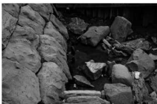
3-1区石堤表法基底部留杭（北から）
