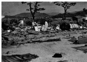
写真3 昭和36年災害状況(北西から)
