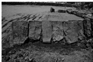
3-1区擁壁部石堤表法2段目上面（東から）
