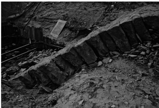
3-1区石堤表法断面（南東から）
