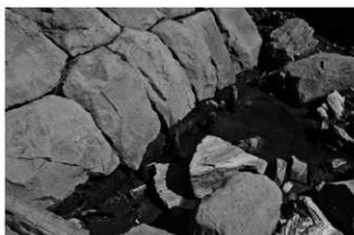
3-1区石堤表法基底部胴木及び留杭（北西から）
