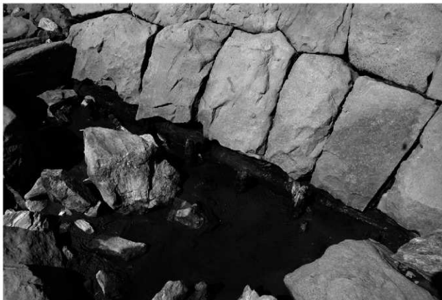
3-1区石堤表法基底部胴木及び留杭（南西から）
