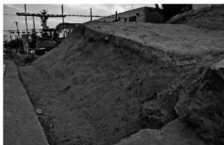
2区土堤北側断面（北西から）
