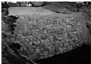
図-3 中央部堤防前面の石積と背後の土堤の様子
