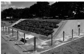
石堤移築完了状況（南西から）
