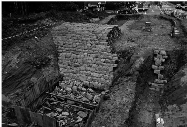
3区石堤表法全景（南西から）
