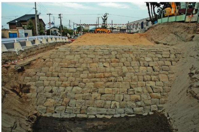
2区中堤防全景（西から）
