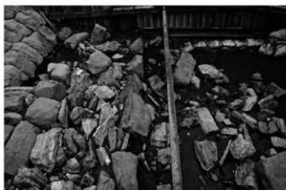
3-1区石敷2段目杭列（北から）
