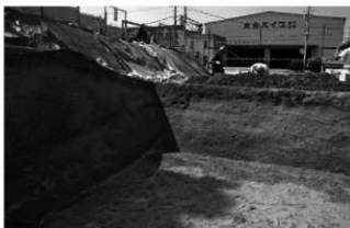
2区土堤掘削状況（北東から）
