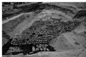
写真2 確認調査 中堤防南端部(南から) (11)
