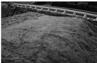
2区土堤全景（南東から）
