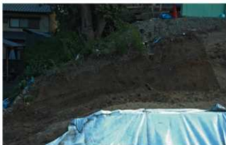
2区中堤防上堆積土層：土堤東半（北から）
