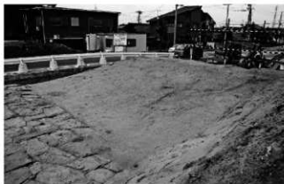
2区土堤全景（南西から）
