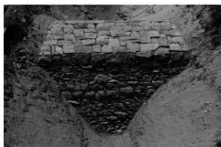
1 区石堤天端・裏法全景（東から）
