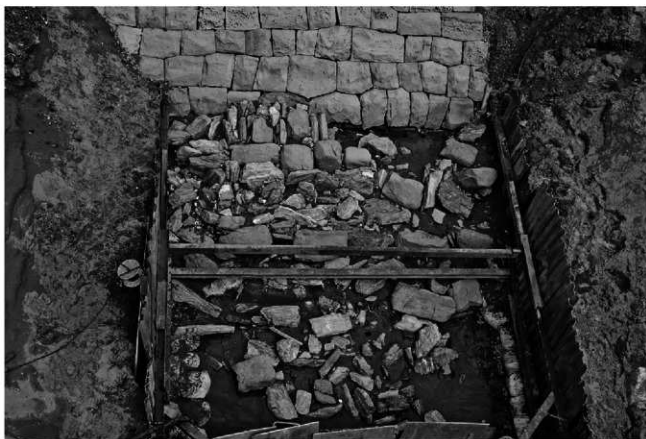
3-1区石敷全景（西から）
