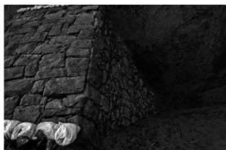
1 区石堤表法全景（南東から）
