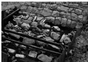
図-6 堤防先方の根固めの様子
