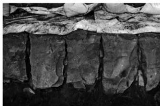
2区石堤解体後表法7段目石材上面（東から）
