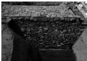
図-5 堤防背面の石積の様子
