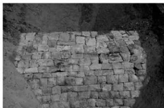
1 区石堤天端全景（西から）
