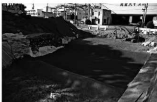
2区石堤解体後養生状況（北東から）
