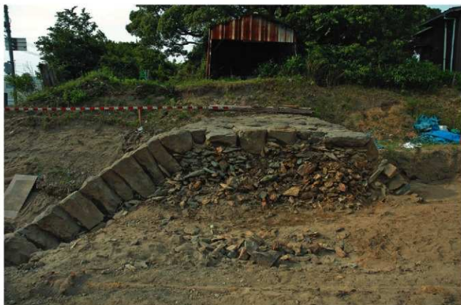
3-1区石堤断面（南から）
