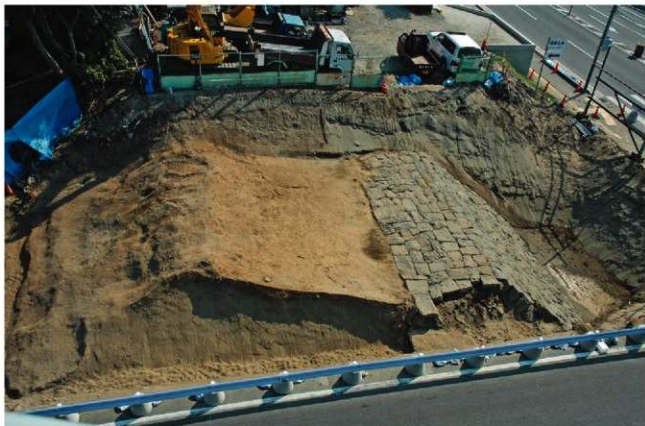
2区中堤防全景（北から）
