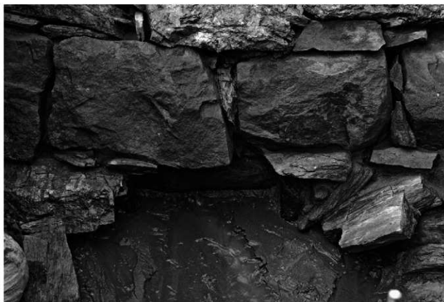
4区石堤裏法基底部前面礫除去状況：サブトレンチ3（東から）
