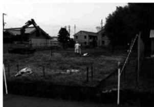
1区 調査区全景（北から）
