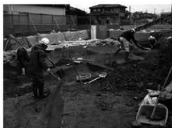
写真3 遺構掘削作業
