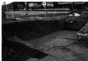
1区 北端011東西溝調査風景（南西から）
