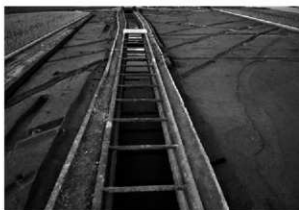
7013-8013 溝（現行水路の両脇、南から）
