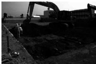
06-3 機械掘削状況（北東から）
