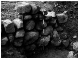
写真38 Ⅱ区 第三面111 塀基礎石積み (07-j6: 北東から)
