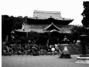
写真3 粉河寺本堂と名勝粉河寺庭園
