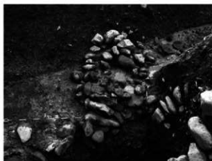
写真45 Ⅱ区 第Ⅳ面 139排水溝東側溝 (石組崩落状態：北東から)
