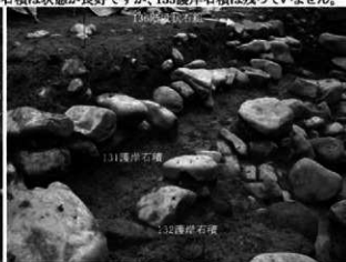
3 II 区西側 第IV面131・132護岸石積(東北東から)
