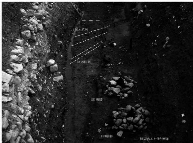
1 II 区 第VI面主要遺構全景(西から) やはり、調査の終わり間際にはいろんなものが出てくるというジンクス通りでした。この写真は、写真図版20-5で報告した第V面のさらに下(第VI面)から見つかった構造物です。既に調査を始めた地表面から約3~4.5mも下に埋もれていた橋脚・水側としてのハネ構造をもつ木杭列などを検出しました。
