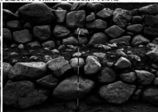
3 第三面111基礎礎・112大走りの積み石の状態(北から)
