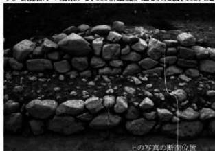
2 第三面111基礎礎・112大走りの積み石の状態(北から)
