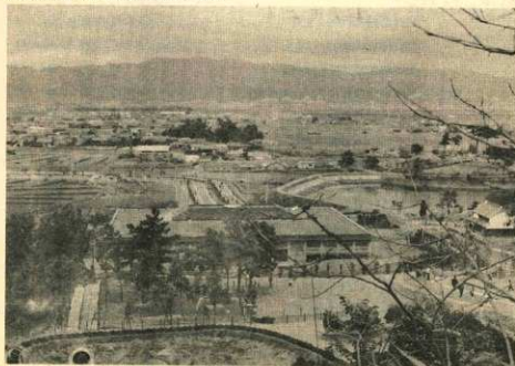
建設後の全上風景 (昭和47. 3. 31)
