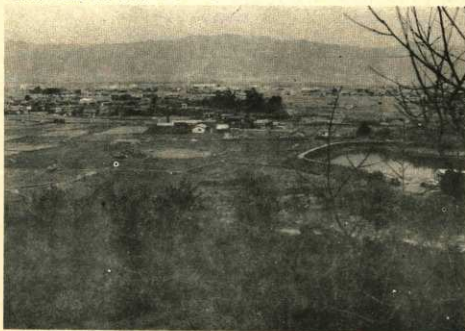
建設前の山麓部風景 (昭和45. 1. 29)
