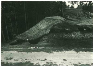
本丸地区Ⅰ区隅櫓土層断面
