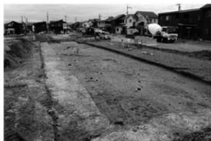
遺構完掘状況（南から）
