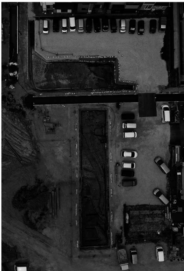
全体俯瞰写真
