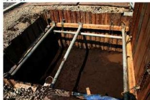
8. 第3調査区調査状況
