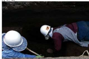
2. 第1調査区 SD003 掘削状況（東より）
