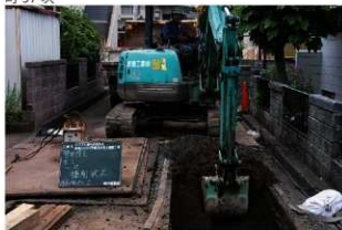
1. 第1調査区機械掘削状況（南より）
