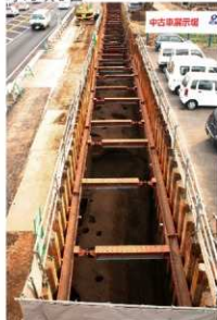
9. 完掘状況 (北より)
