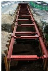
7. 遺構②検出状況（北より）
