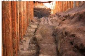
23.SD200 完掘状況 (南より)
