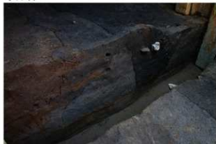
4. 南側トレンチ掘り下げ状況（北より）
