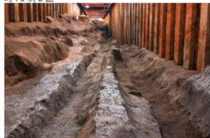
22.SD200 完掘状況 (北より)
