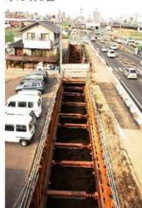
8. 完掘状況 (南より)
