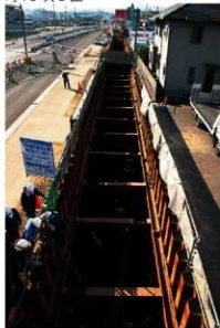
7. 掘り下げ状況 (北より)
