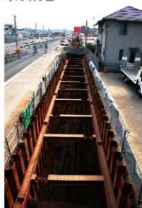
26. 完掘状況 (北より)
