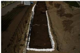
4. ②道構検出状況 (南より)
