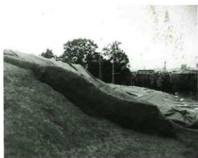
新開3号墳崩落土
