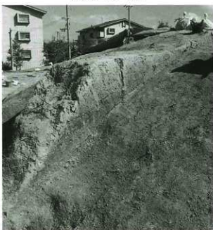
新開5号墳 崩落土
