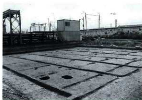
C区4トレンチ完掘状況
