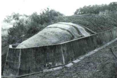
盛土除去後 保護シートの状況
