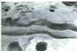
2. SH-9 壁溝拡張部分
