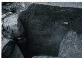
西側側壁裏込め
