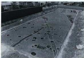
調査地全景（南から撮影）
