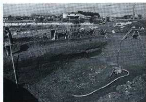
SR-3 完掘状況
