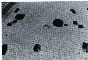
SB-2 断ち割り状況
