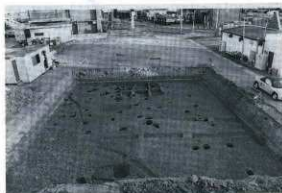
調査区北側全景
