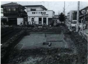
調査地西側完掘状況
