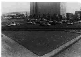
3 トレンチ完掘状況（北から）
