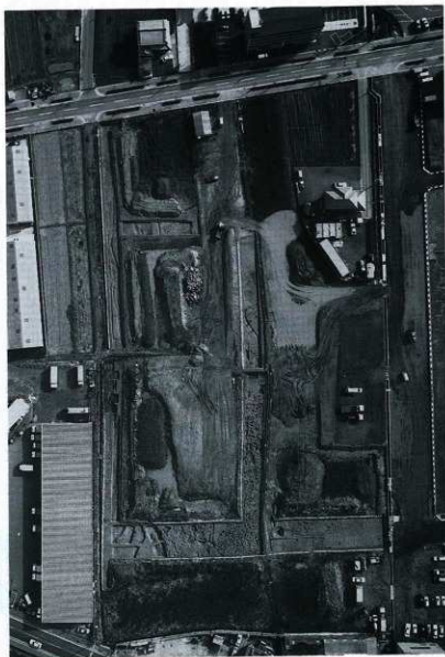
C調査区全景（上空より）
