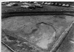
1 トレンチ完掘状況（北から）
