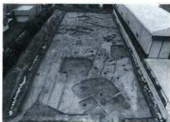
調査区南東から北西方向をみる
