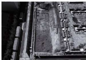
C区、D区全景（写真上が西北）
