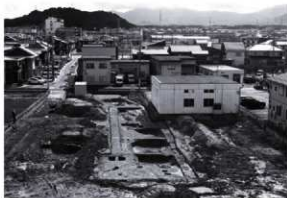
調査地遠景（北西から）
