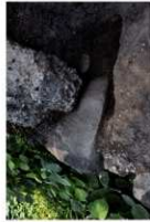
①A区北端 縁場と盛石の間隙 (西から)
