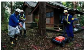
第 58 図 地中レーダー探査の様子
