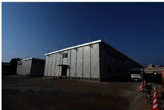
建物屋根・外壁完成
