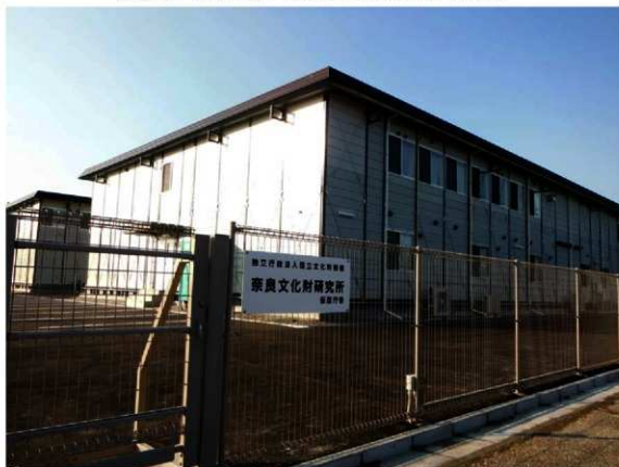
仮設庁舎 (H25.12.3 仮設庁舎北東方向より撮影)
