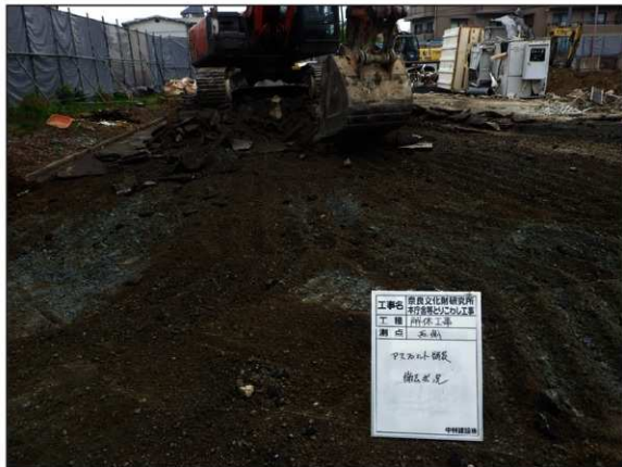
解体作業状況（アスファルト舗装撤去）
