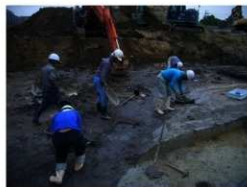
② 6/17 秋篠川旧流路の南岸を掘り下げています。
