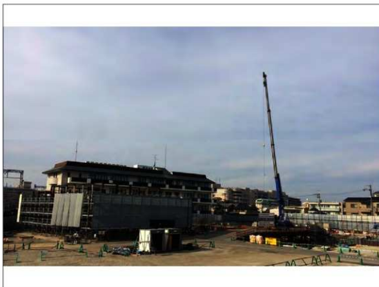
鉄骨及び地下躯体工事状況（平成28年12月）
