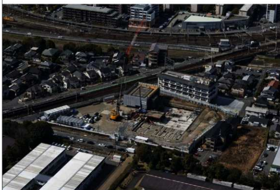
北棟地下・基礎躯体工事状況（平成29年3月）
