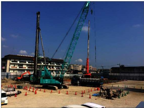
地下掘削及び杭工事状況（平成28年8月）
