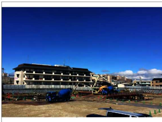
基礎工事状況 (平成28年10月)
