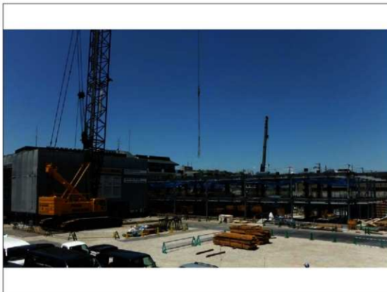
北棟 1・2 階躯体工事状況（平成 29 年 5 月）
