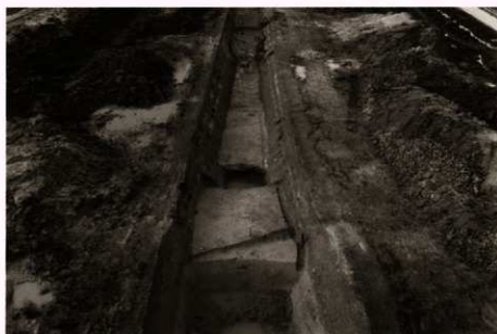
(2) 第8トレンチ(東から)
